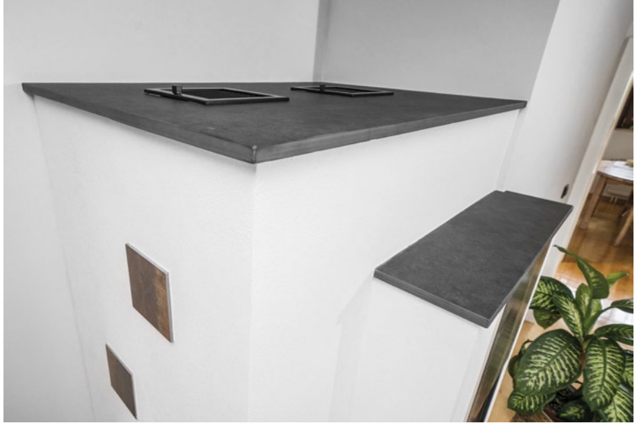
Die Abdeckungen aus Schiefer schaffen einen interessanten Kontrast zur hellen Putzoberfläche des Ofens.
