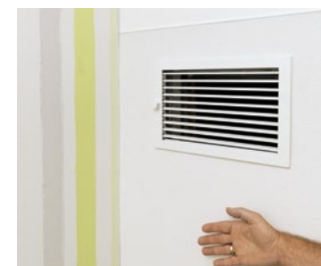
Die Wärme gelangt über Luftgitter in die benachbarten Räume.
