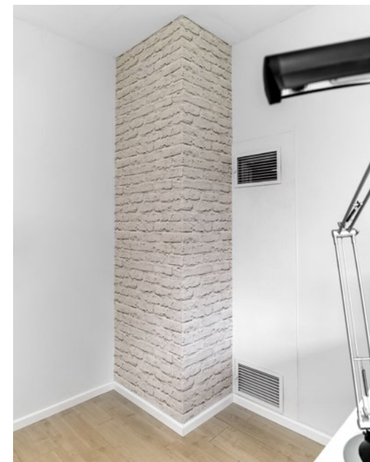
Die Wärme gelangt über Luftgitter in die benachbarten Räume.
