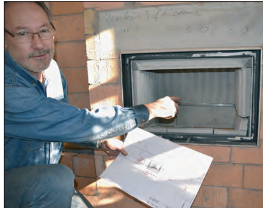
Achim Gelhard zeigt, wie die Feuerung mit Schamott-Steinen ausgekleidet wird.
